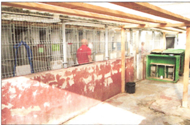
Instalaciones de la perrera municipal. / BEDIA
