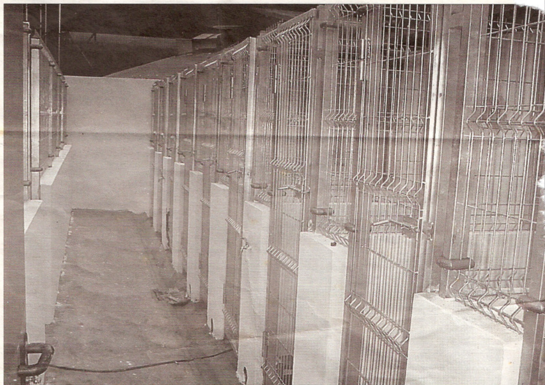
Interior de las instalaciones de la Perrera Municipal de Laredo.
